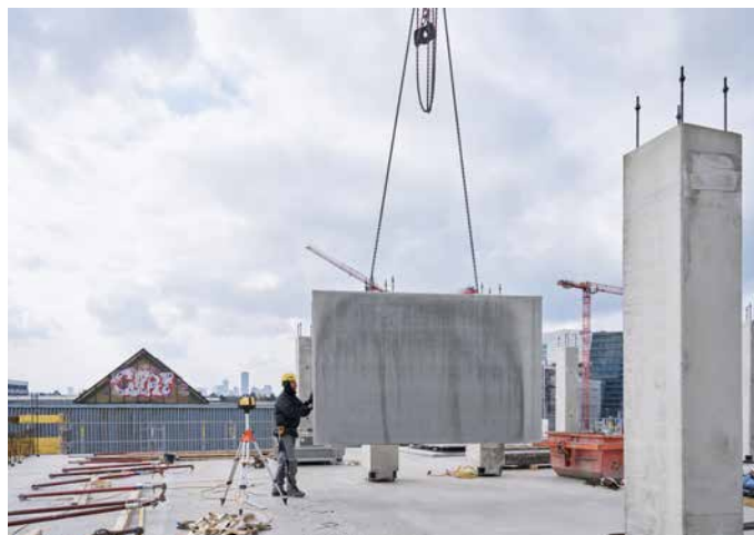
Der kubische Baukörper ermöglicht hohe Traglasten und die Umsetzung des komplexen Brandschutzes
