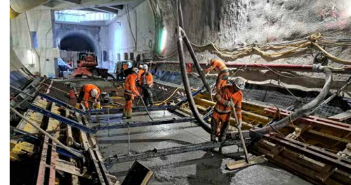
Der Ausbau der U2 und U5 in Wien ist ohne den stabilen und langlebigen Baustoff Beton nicht denkbar
