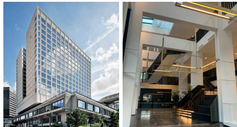
Die Sanierung mit hohem Re-Use-Anteil ist ein Best Practice für kreislauffähiges Umbauen
